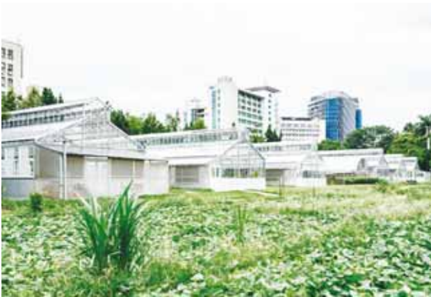
智慧溫室共計六棟溫室
