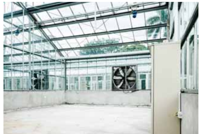
溫室設置電動天窗、負壓風扇、水簾及獨立控制箱等設備
