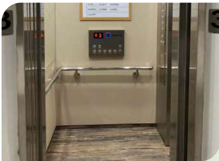
行政大樓無障礙電梯
