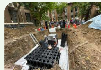
鋪設雨水積磚，改善庭園的積水問題
